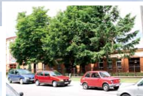
Wybudowany w 2005 roku łącznik
