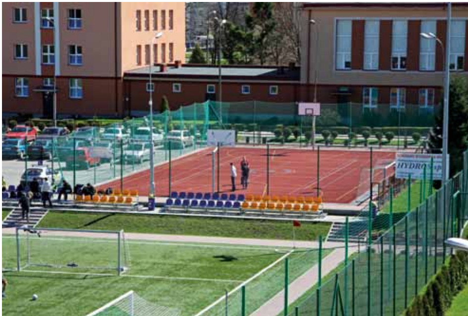
Wybudowane w 2009 roku boisko wielofunkcyjne z poliuretanu
