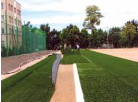
Budowa nowoczesnego boiska ze sztuczną nawierzchnią – maj 2008 r.
