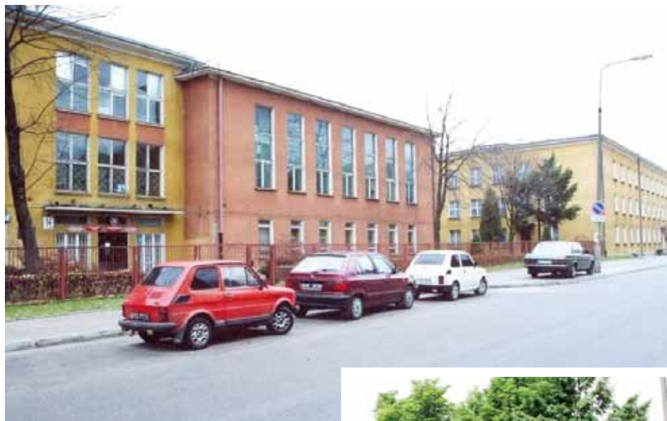
Budynek A i internat przed wybudowaniem łącznika – 2001 r.
