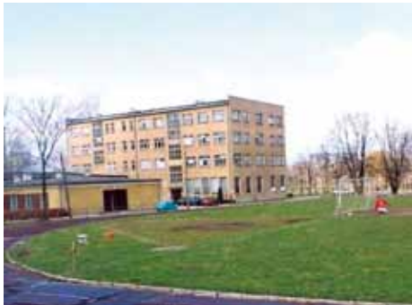
Widok na budynek B i warsztaty przed remontem
